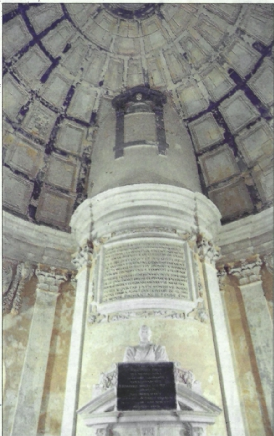
La chapelle Notre-Dame de Cordouan est l'une des salles qui font partie de la visite du phare. Son état avant travaux.
