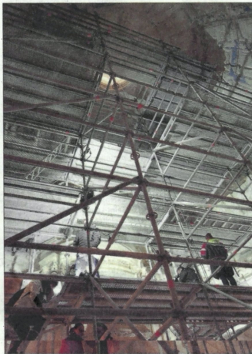
Le chantier de restauration de la chapelle a nécessité l'installation d'un échafaudage.
