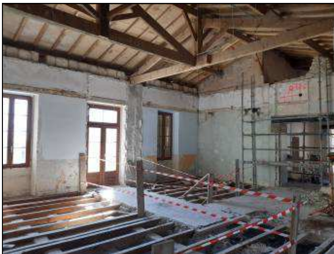
Le 2 ème appartement en chantier (extension du musée).
